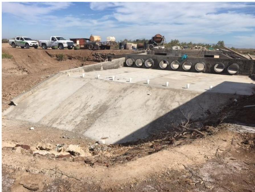
**Figura II.2** Cárcamo de bombeo y SEFA de la granja Poder Acuícola S.A. de C.V
