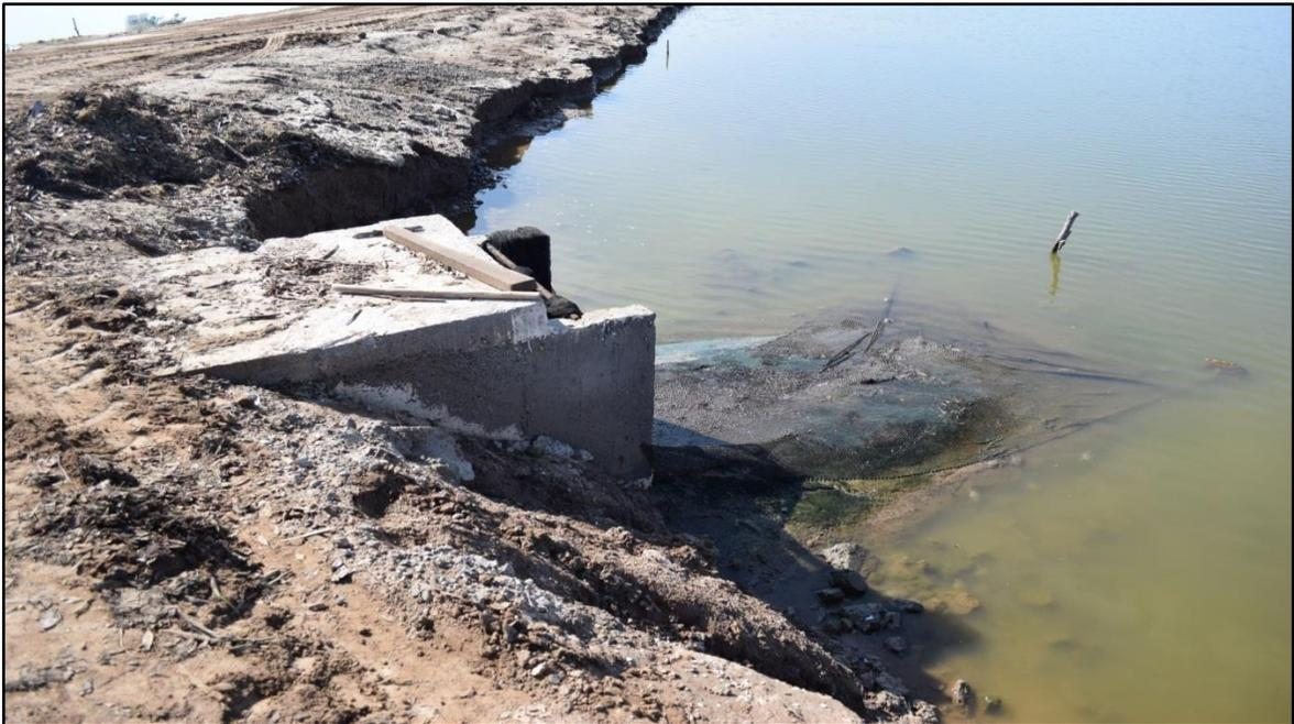
Compuerta de descarga y filtro tipo "condón" para retención de fauna de acompañamiento.
