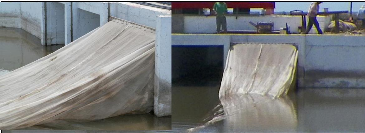
Fotografía de ejemplo de instalación de una malla de seguridad. La fotografía corresponde a la granja acuícola La Línea.
