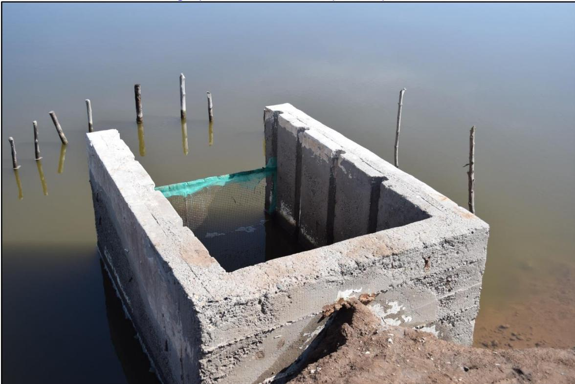
Tipo de compuerta de entrada construida en la granja.
