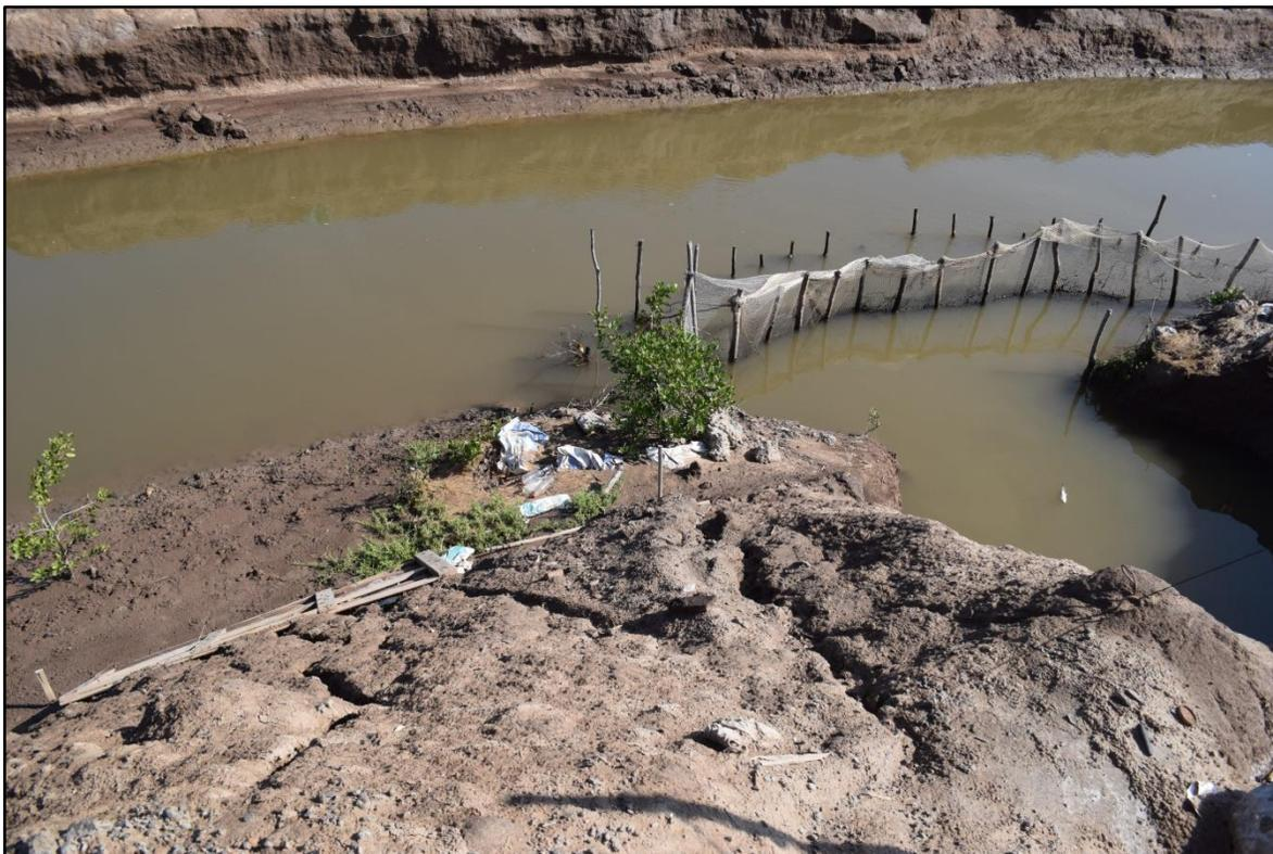
Filtro de malla colocado previo a la zona de succión del cárcamo No. 2. Se observan plantas de vidrillo y mangle.
