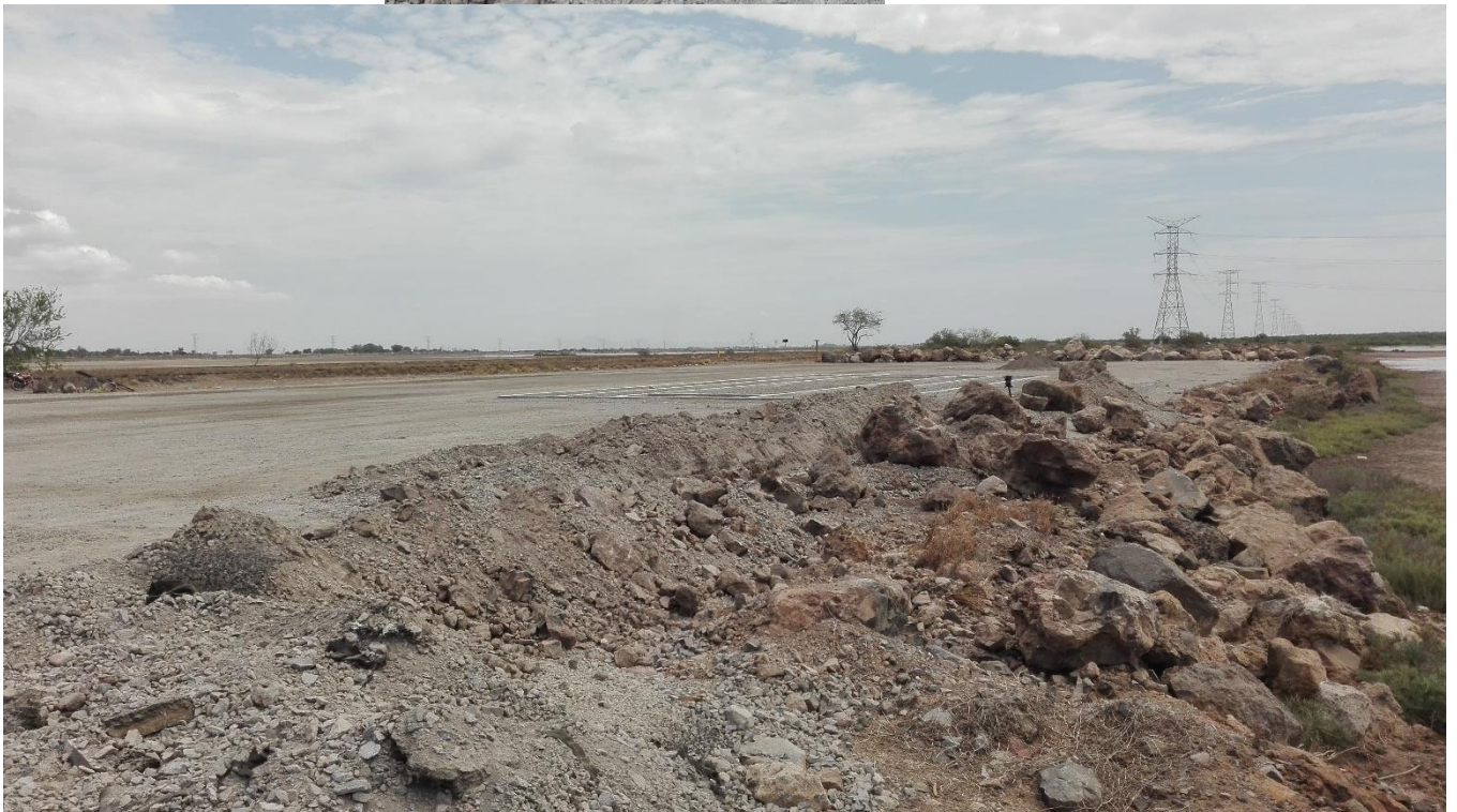
Figura 2.6 Trabajos efectuados en relación al mejoramiento del suelo
