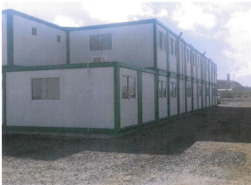
Figura 2.7 Condición actual "Oficinas y salones de capacitación"
