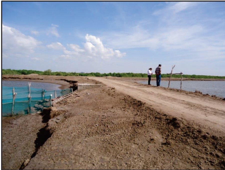
Figura IV.12. Vista de las obras en estudio prácticamente desprovistas de vegetación
