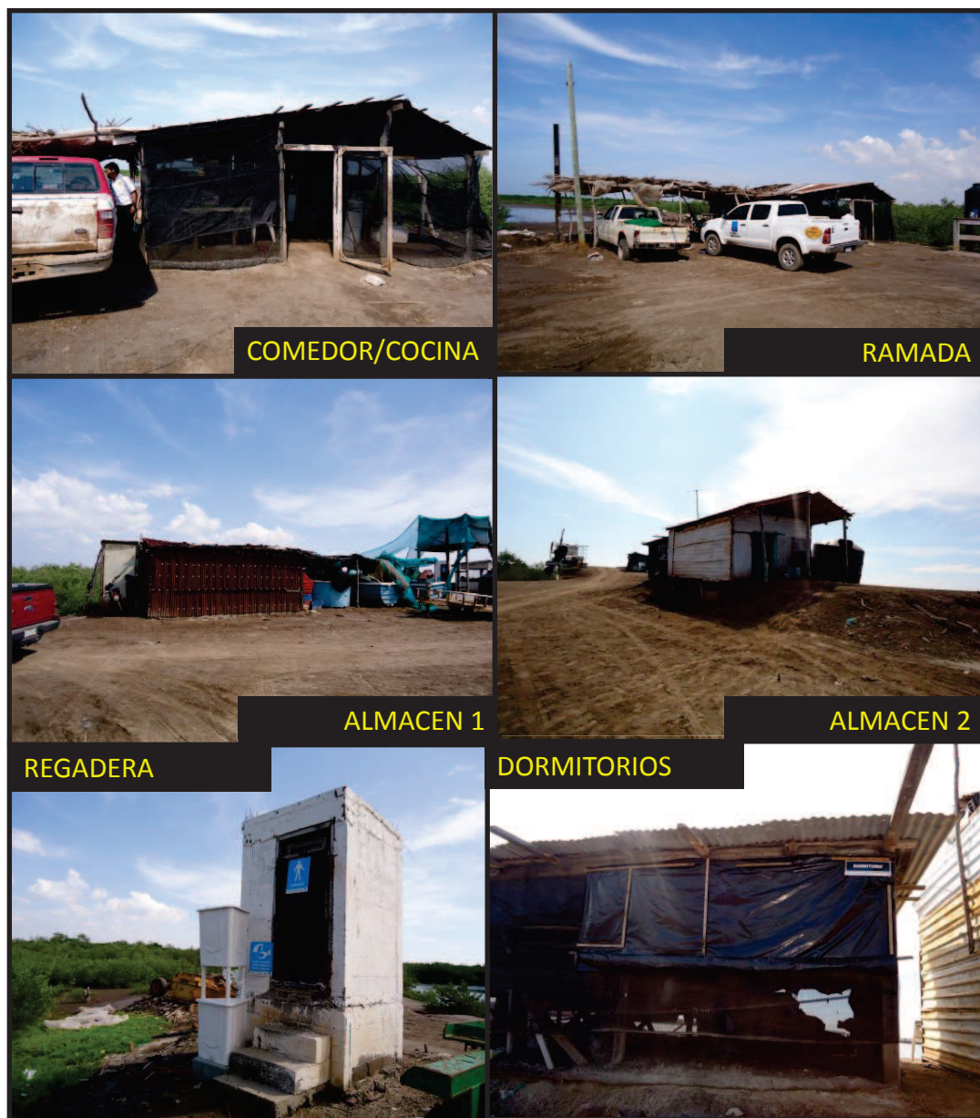
Figura II.7 Instalaciones de las obras auxiliares de Acuícola Open Sea
