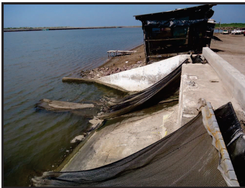
Figura II.4. Vista del reservorio y sus medios de control de fauna acuática
