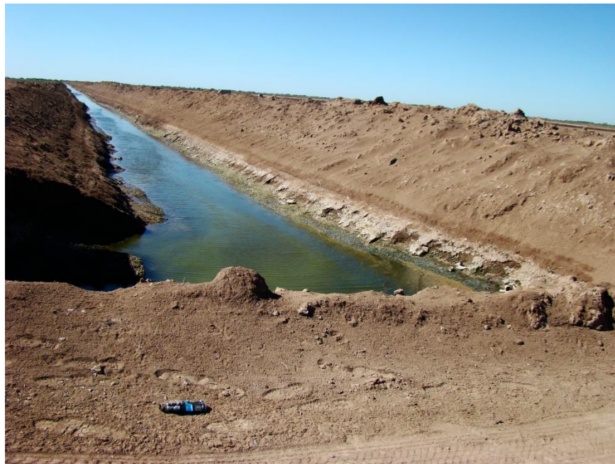
Figura 2.5 Canal de llamada existente.
