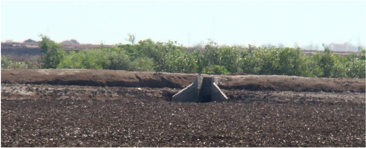
Figura 2.8 Dren de descarga
