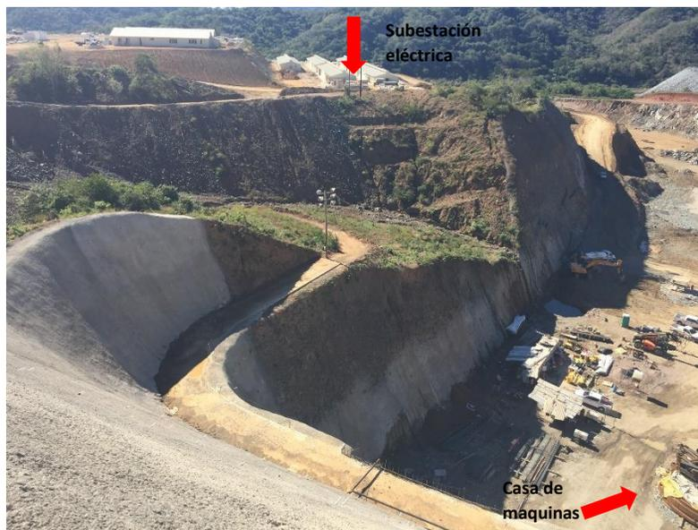
**Figura IV. 15. Ubicación del área del proyecto en referencia de la actual construcción de la Presa Santa María.**
