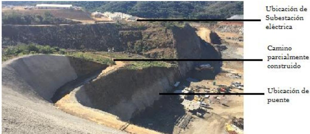
**Figura II. 15. Construcción del puente y camino.**
