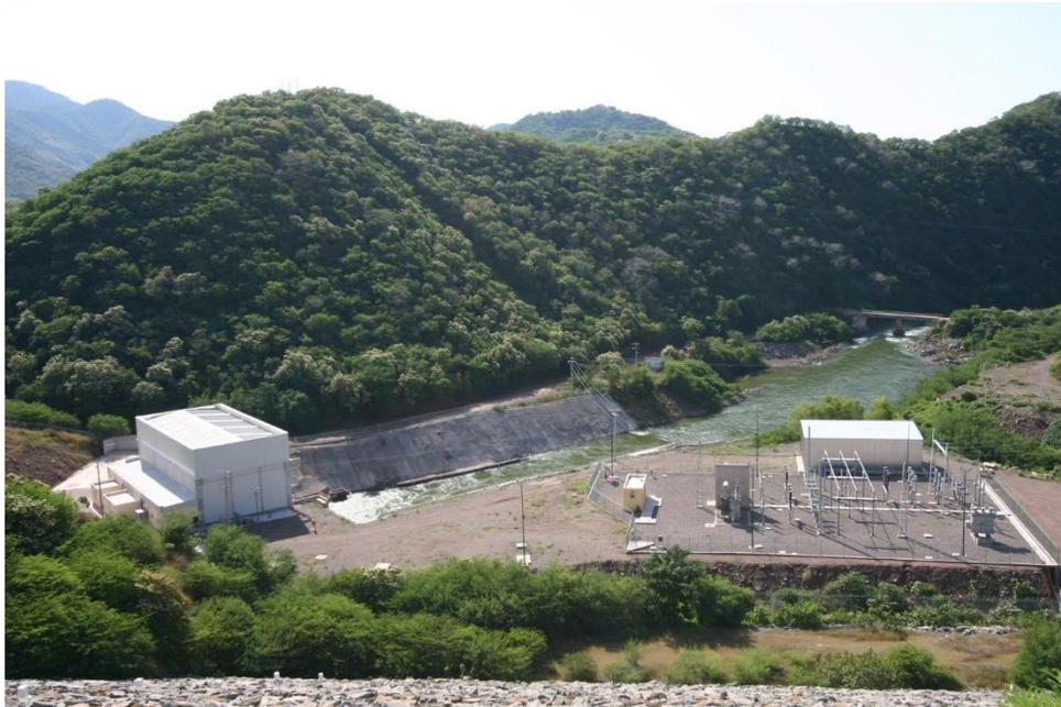
Figura II. 17. Ejemplo de instalación de una casa de máquinas (Central Hidroeléctrica El Gallo)<sup>9</sup>.
