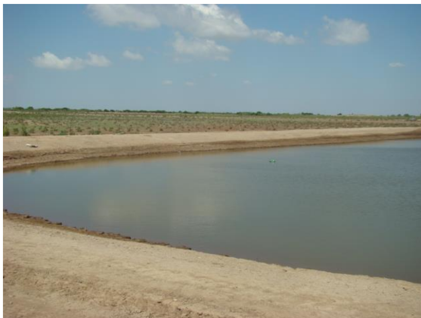
Figura 2.5 Escenario Actual de los estanques Sección 2.
