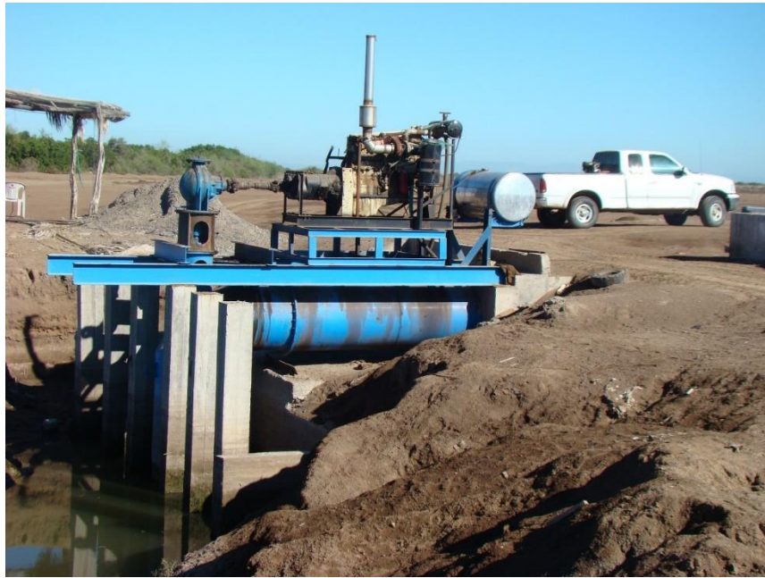
Figura 2.9 Escenario Actual cárcamo de bombeo en Sección 1.
