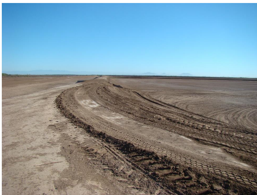
Figura 2.6 Escenario Actual de los estanques Sección 1.
