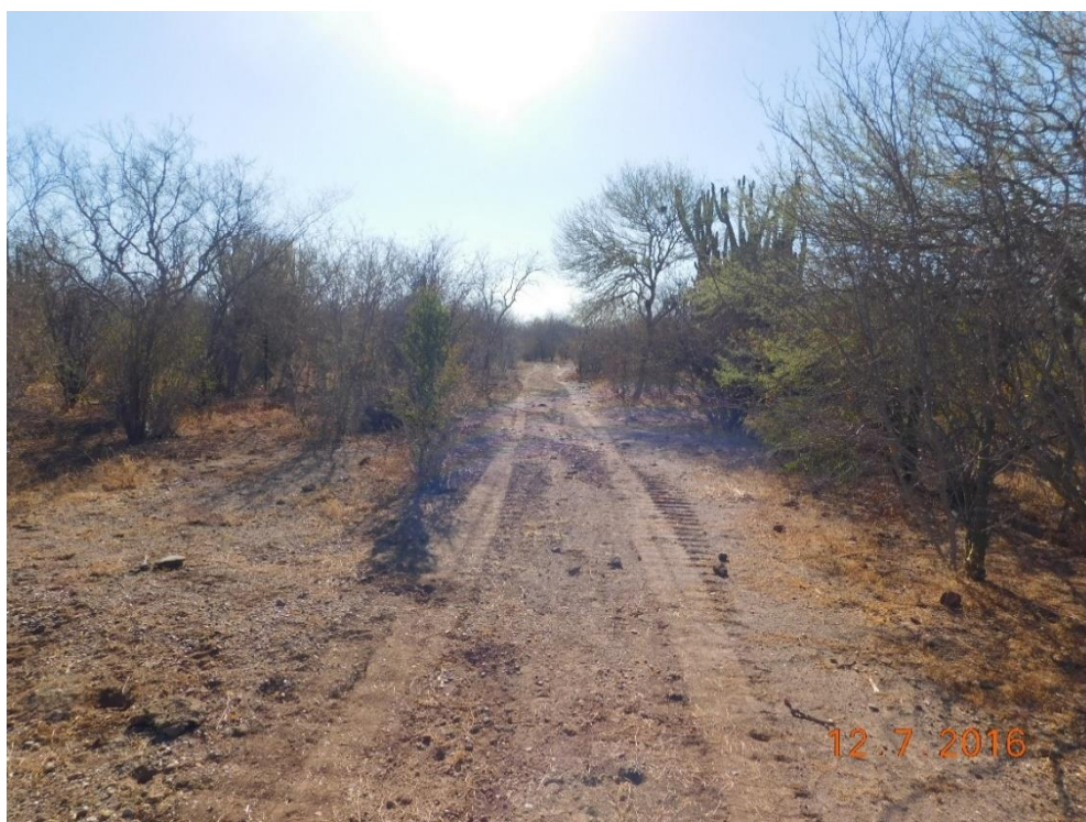
Figura VII.4. Vista general de la zona durante la construcción del proyecto (ejemplo).
