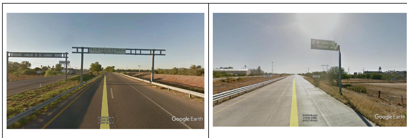
Figura IV.46. Vista general de la carretera federal No 15 (tramo Ciudad Obregón - Navojoa)
