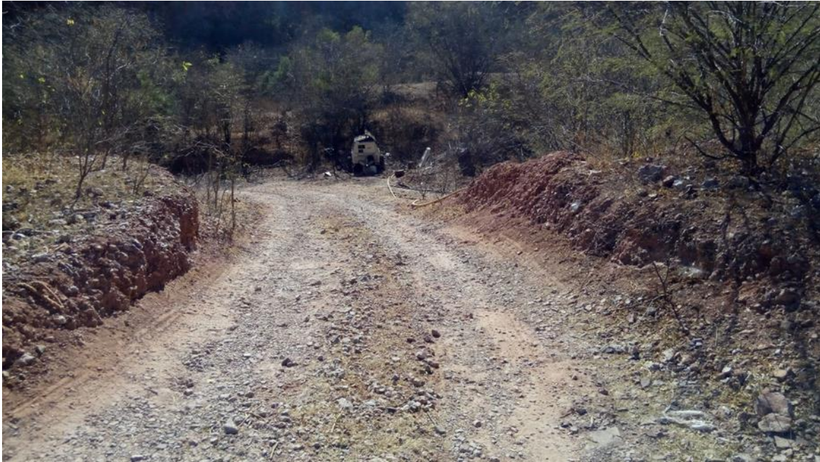
Foto 27.- camino de absceso a las caleras se observa el revestimiento del desecho de la fragmentación de la piedra caliza.
