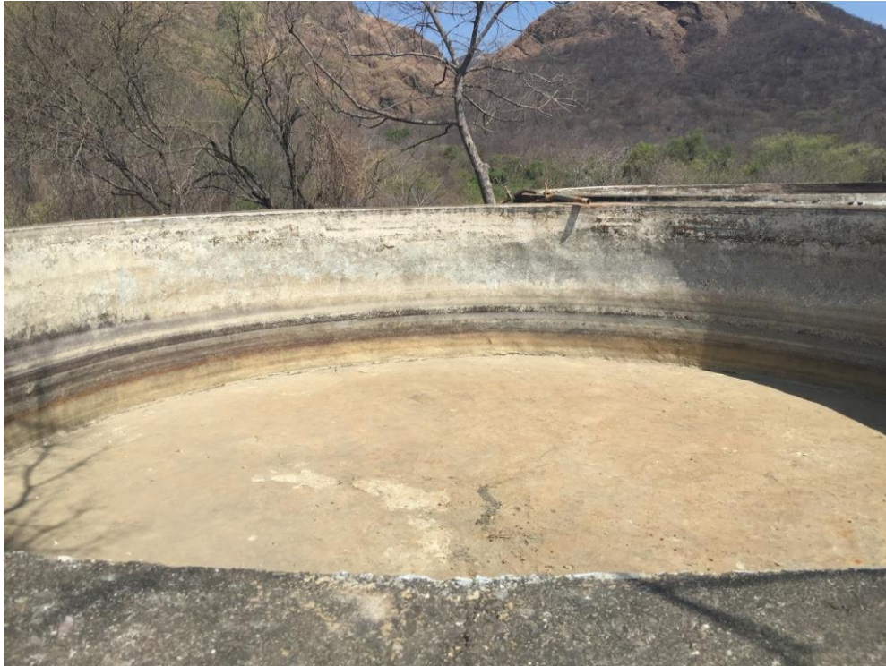
Fotografía 1. Area de piletas.
