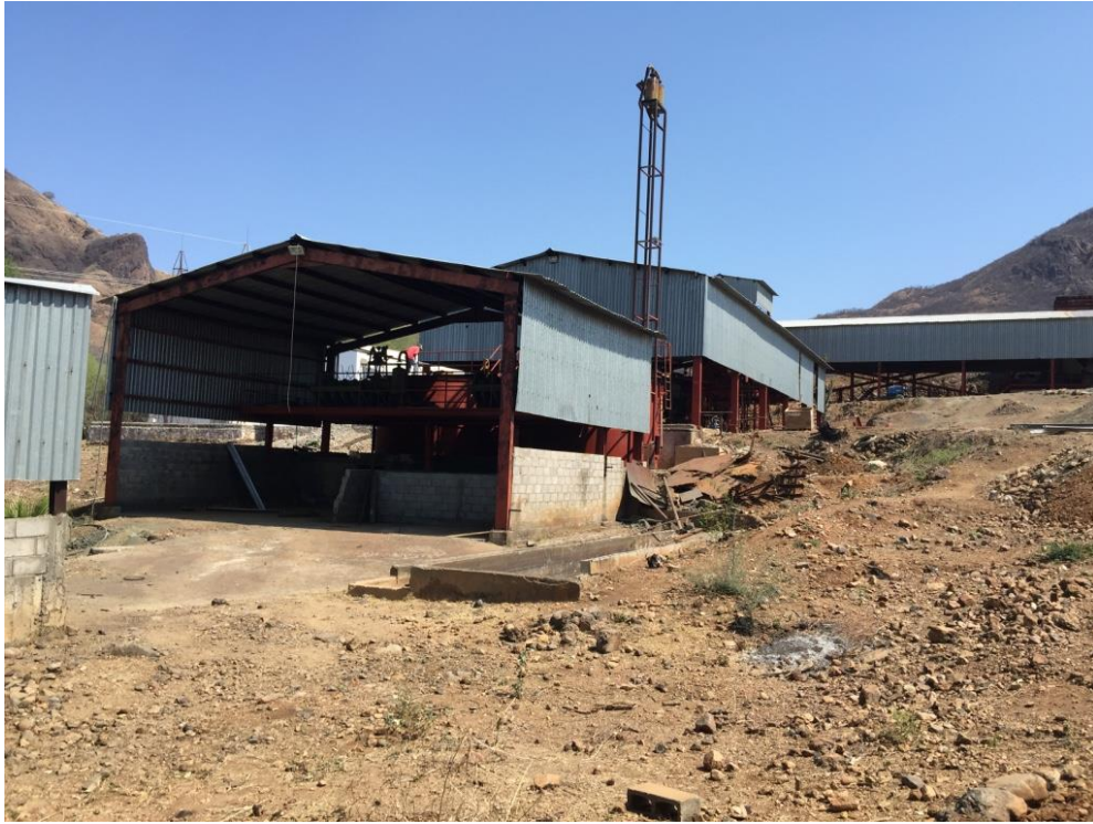
Fotografía 5. Panorámica de la infraestructura el proceso existente.
