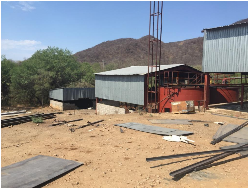
Fotografía 2. Infraestructura existente y que se rehabilitara.
