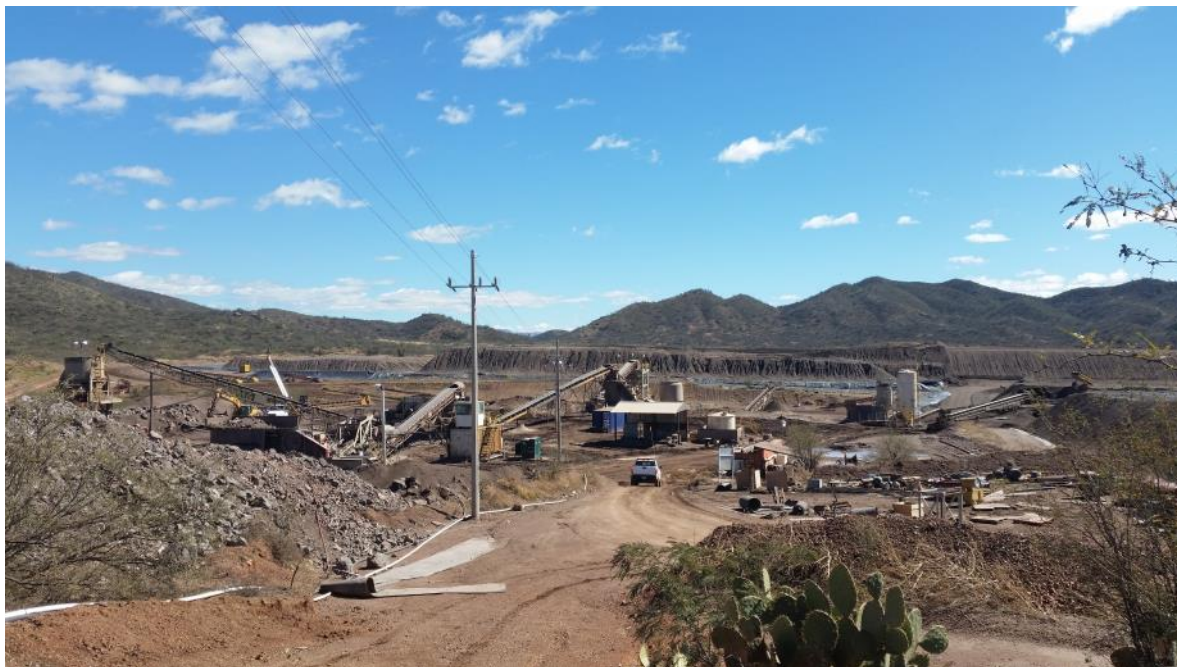
Operación actual.- Trituradora o quebradora en “Cerro Prieto”
