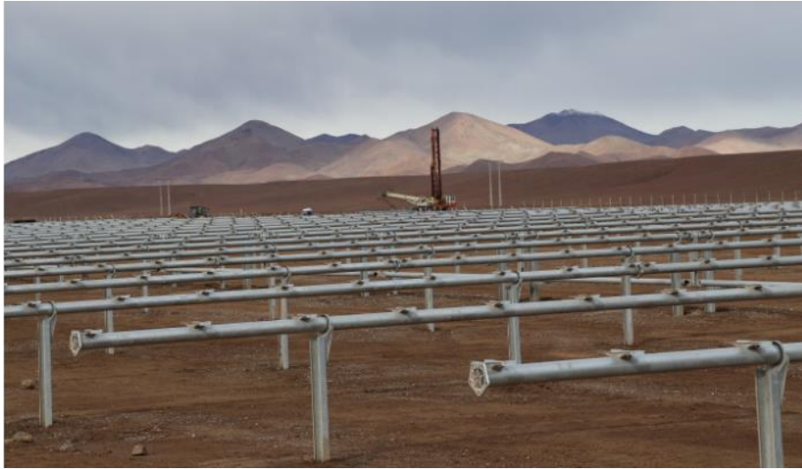
Figura II. 6 Instalación de tubos de rotación
