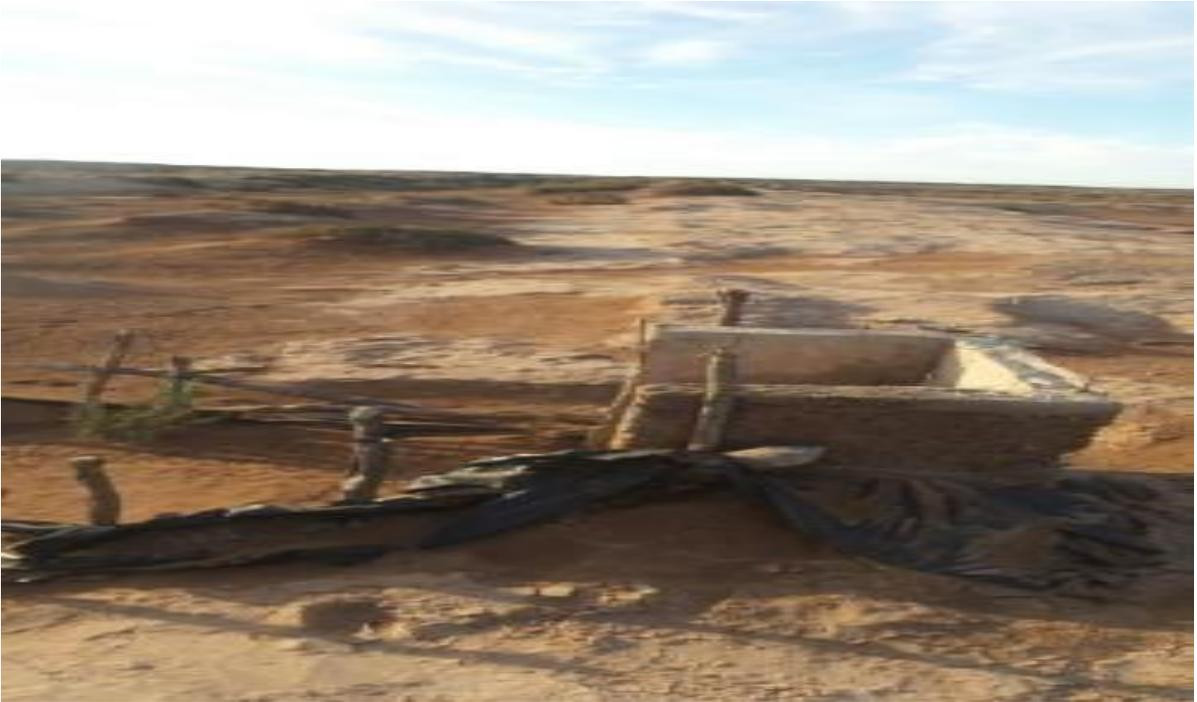
Foto 5. Compuertas de entrada en completo deterioro en ambas secciones.
