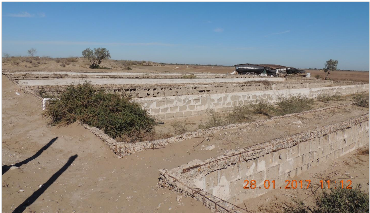
Figura 34. Fotografía de piletas de maternidad existentes fuera de operación por malas condiciones en la granja San Antonio, municipio de Huatabampo, Sonora.
