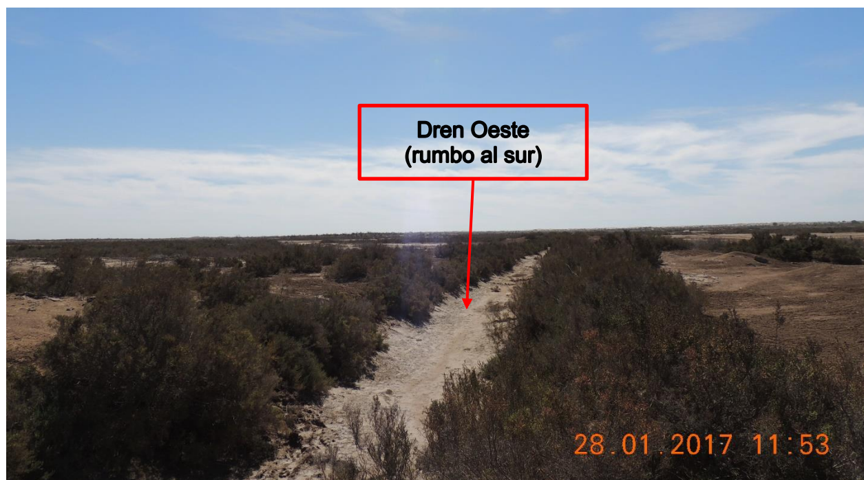
Figura 30. Vista fotográfica de la condición de azolve del dren (oeste) del predio donde se desarrollará el proyecto de ampliación y operación de granja productora de camarón en el municipio de Huatabampo, Sonora.
