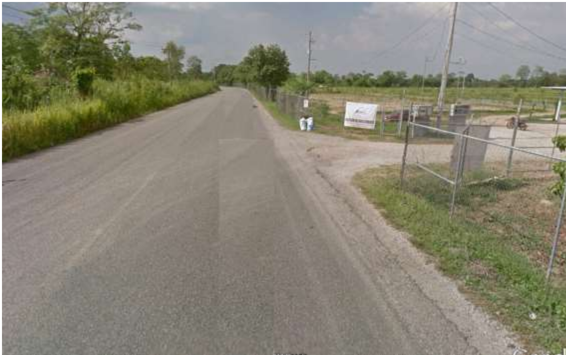
Ilustración 4. Carretera Federal Villahermosa-Jalpa.
