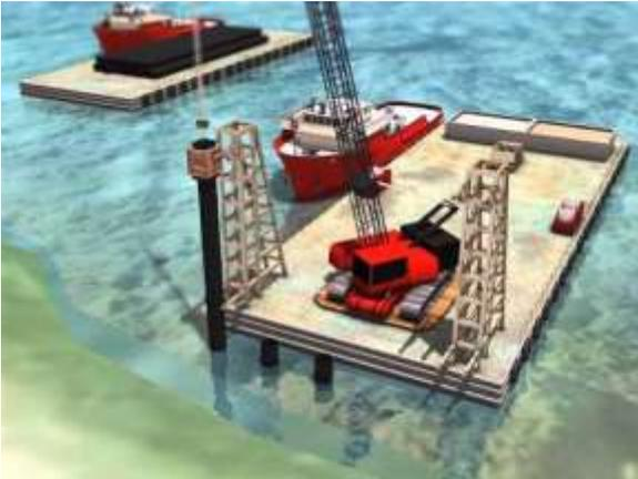
Figura 7.- Ejemplo del proceso de Hincado de pilotes por medio de chalán y grúa.
