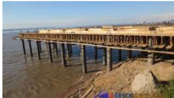
**Armado de tarima de madera:** se refiere a la colocación de madera sobre la estructura formada con los pilotes, el área estará totalmente recubierta de madera para que sobre ella se pueda transitar y ésta a su vez.
