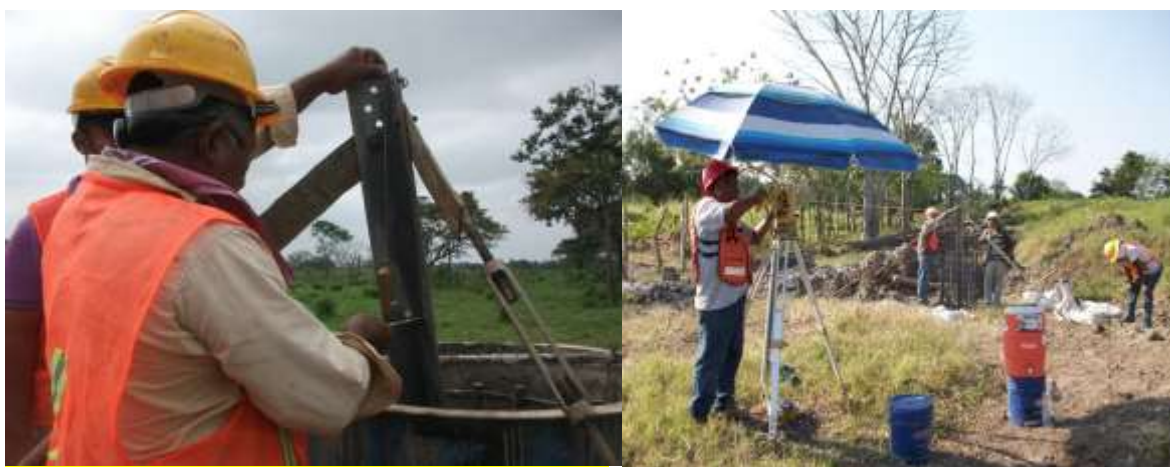
Figura II.10 Nivelación de los stub de las estructuras.
