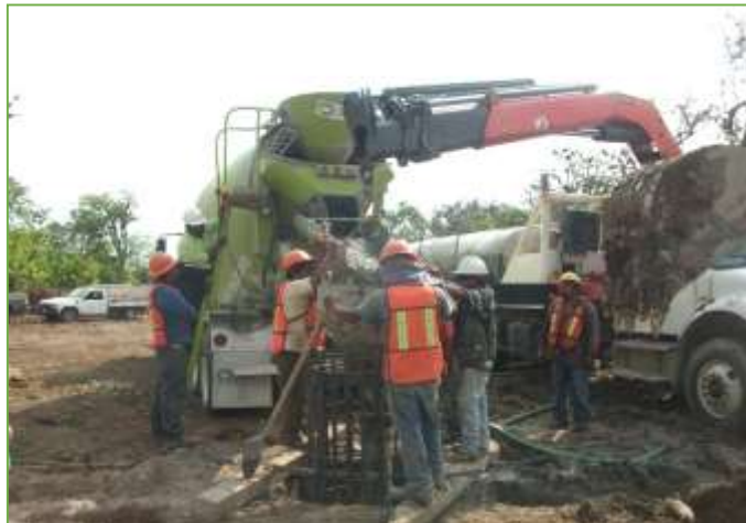
Figura. II.17 Colado de pilas
