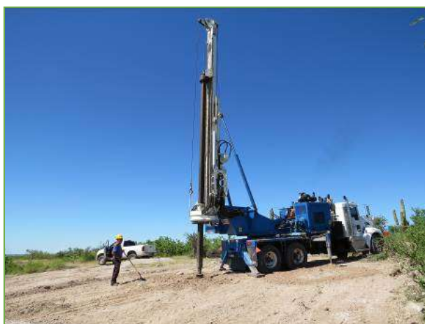
Figura II.15 Perforación de pilas con maquinaria tipo texoma.
