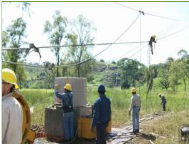
Fig. II.20 Proceso de tendido y tensionado de cable conductor y de guarda.
