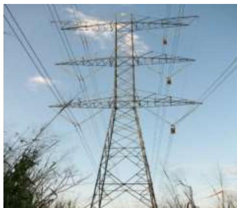
Figura II.13 Se observa equipo para el devanado de cable conductor
