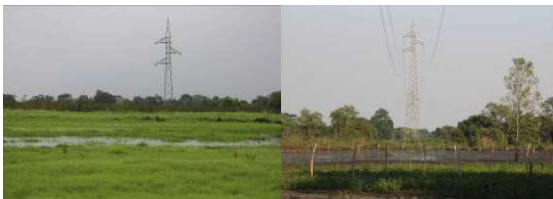
Figura VII.10. Vista general de la zona durante la construcción y operación del proyecto.
