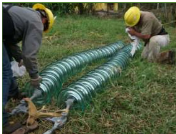
Fig. II.19 Vestido de estructuras y tendido y tensionado de cable conductor y de guarda.
