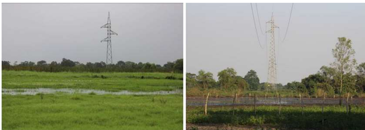
Figura VII.12. Vista general de la zona durante la construcción y operación del proyecto.
