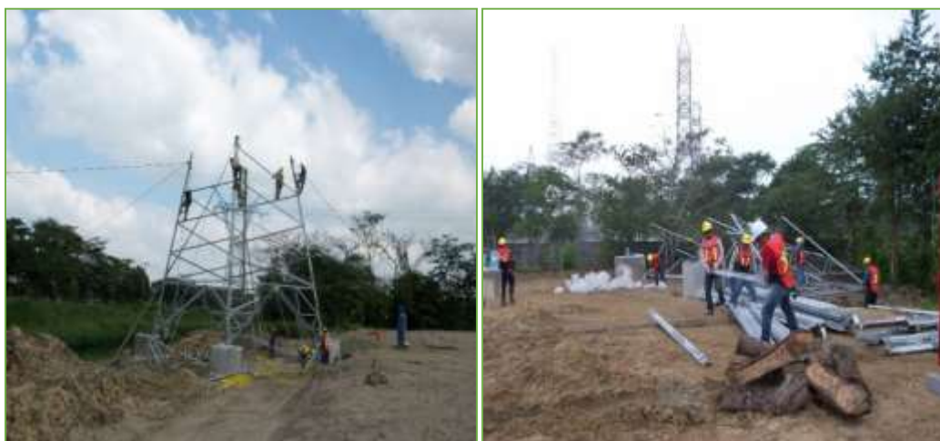
Figura II.18 Armado de estructuras.
