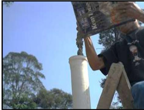
7. Una vez nivelados los pilotes a la altura deseada se colocaran sobre los pilotes (palafitos) través de madera, para ir completando el primer armado, a la par se ira a avanzando con la colocacion del entarimado, Según los avances de hincado de pilotes y colocacion de través. La plataforma debera quedar de 30 a 40 cm sobre el nivel del malecon.
