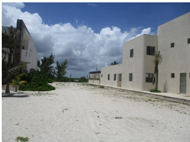
Fotografía 1 Vista de las condiciones actuales del sitio.
