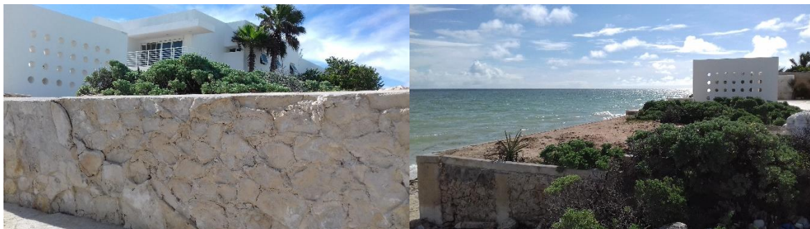
Figura II. 8. Muro de contención de mampostería
