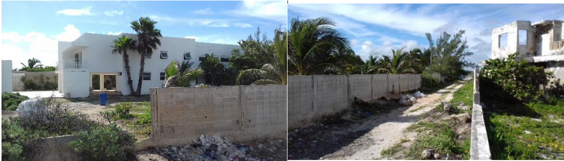
Figura II. 9. Muro Perimetral de block
