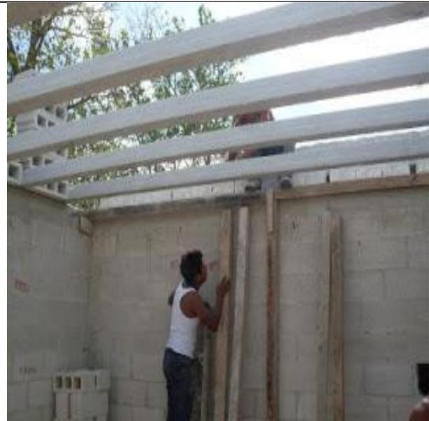
Una vez realizado el colado de cerramientos se procede a asentar viguetas y bovedillas para conformar el techado de los cuartos que conformarán las instalaciones de la bodega para el resguardo de lanchas.
