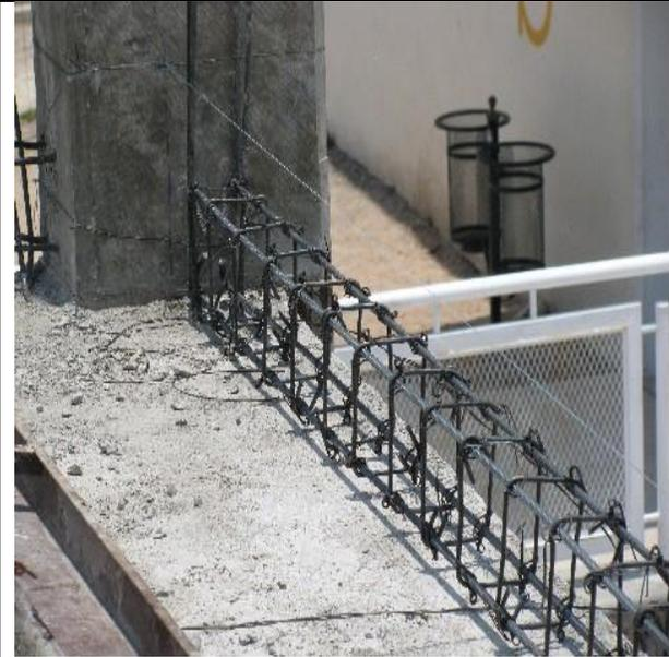
Sobre estos resultará necesaria la colocación de armex para el colado y conformación de las cadenas y castillos de cimentación para sostener muros.
