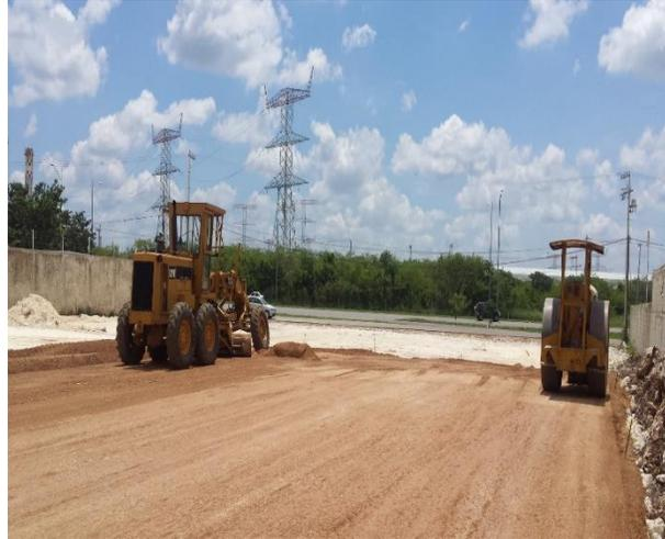
**Imagen II.12-** referencia de los trabajos de compactación del sascab a emplearse como piso de las destinadas a estacionamiento.
