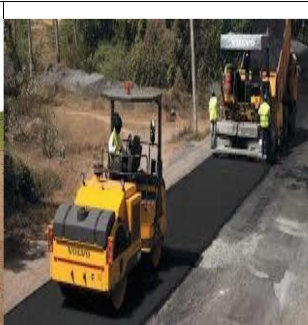
**Imagen II.14.** Empleo de aplanadora y pavimentadora para ir conformando la carpeta asfáltica del estacionamiento y circulaciones internas del proyecto.
