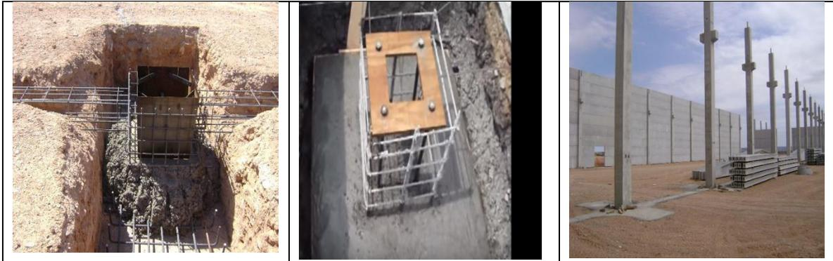
**Imagen II.15.** Imágenes de referencia de zapata aislada, dados, pernos, anclajes y unión con columnas de concreto prefabricado a desplantar.
