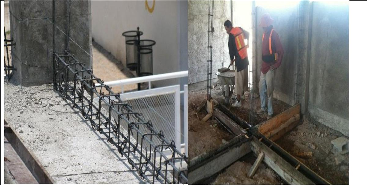
Sobre el techo a base de losas prefabricadas resultará necesaria la colocación de armex para el colado y conformación de las cadenas y castillos de cimentación para sostener muros de los siguientes niveles.
