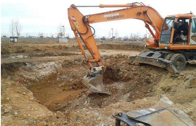
Imagen II.11. Uso de retroexcavadora para excavaciones
