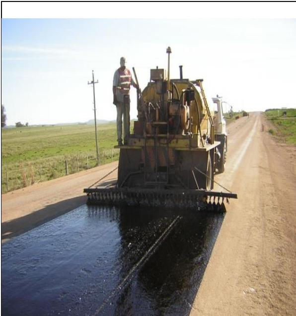
**Imagen II.13-** Riego con chapote en el piso para conformar la carpeta asfáltica.
