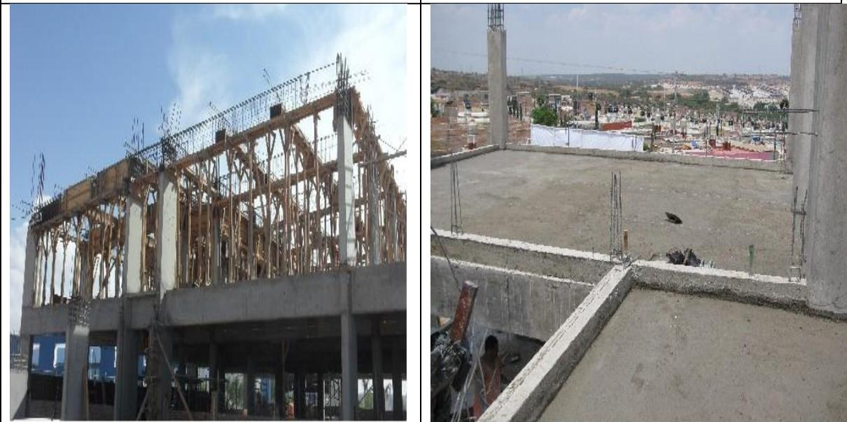
Es de mencionar que todos los niveles estarán conformados de columnas prefabricadas de concreto, viguetas y losas de concreto para desplantar cadenas de cimentación que conformarán los muros de todos los niveles.
