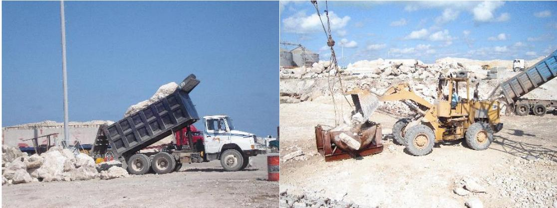
**Figura 2.31.** Fotografías de la llegada de la piedra a la zona de trabajo y del llenado de las charolas con piedra con un cargador frontal a mano derecha
