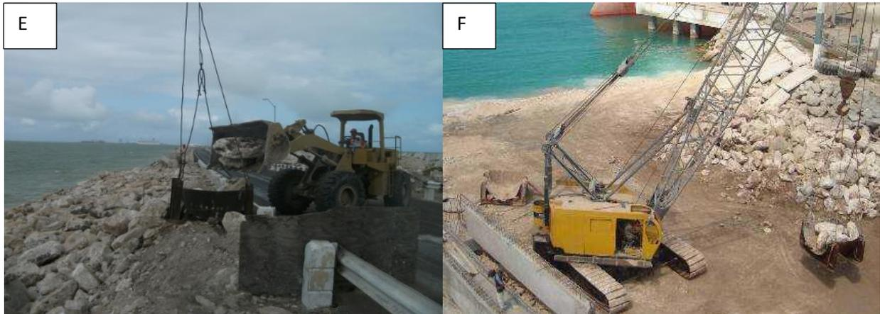
**Figura 2.35.** E) Colocación de piedra mediante excavadora y grúa. F) Charola cargada de piedra para capa de coraza.
