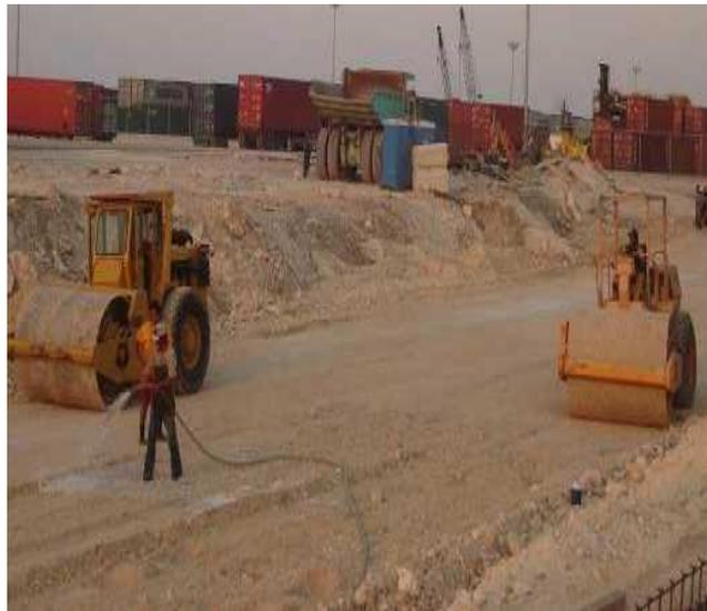
**Figura 2.36.** Compactación de material en zona de relleno.
