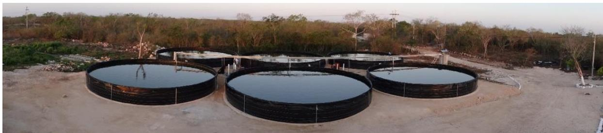
Ilustración 16.-Vista panorámica de un módulo tipo o ejemplo de 6 tanques de geomembrana.
