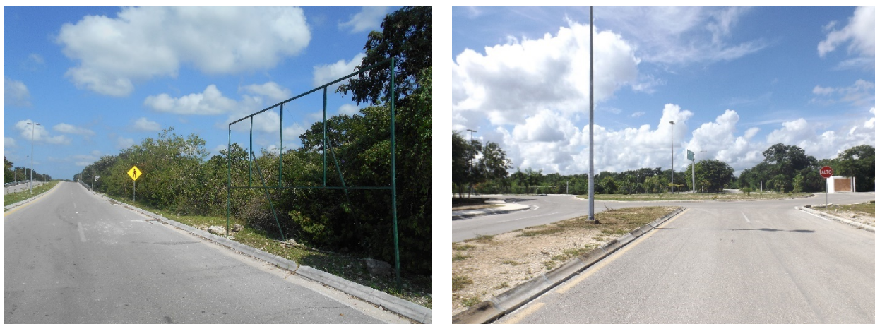
Figura 4.21. Se observan las vialidades internas del Parque Científico que colindan al sitio del proyecto.
