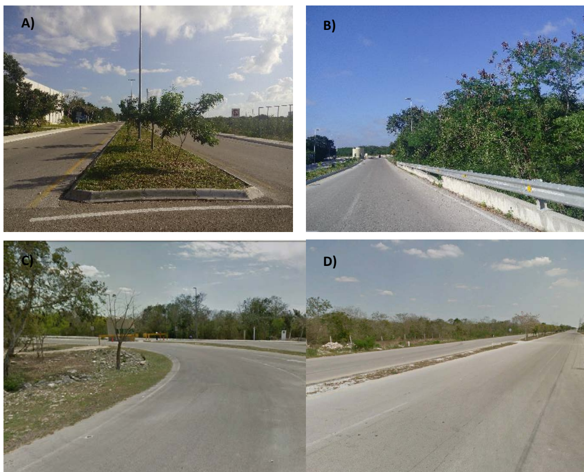
Figura 2.3 A) y B) Se observan las vialidades internas del PCTY y C) D) se observa la caseta de vigilancia de la etapa II y la carretera Sierra Papacal – Chuburná.
