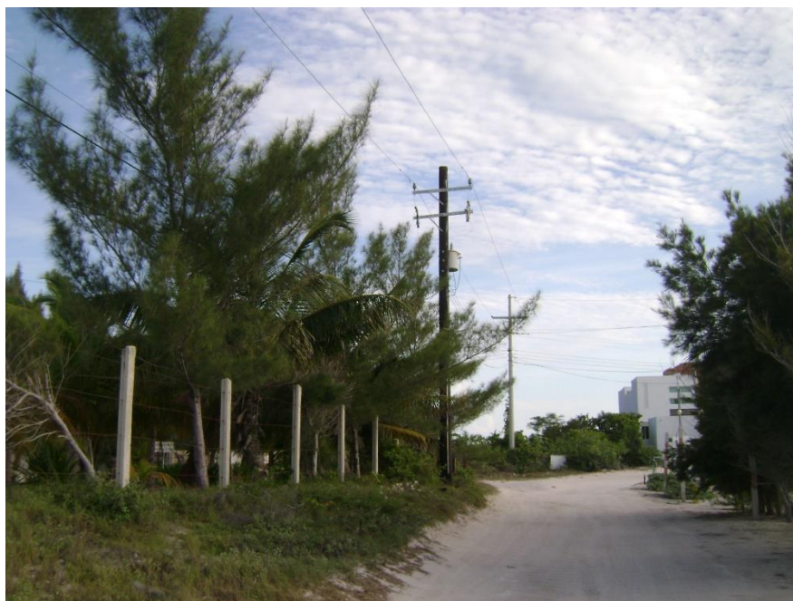
Servicio de energía eléctrica
