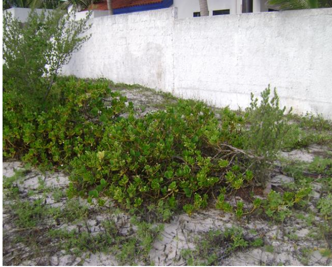
Figura IV. 20.- Construcción de muro que separa al sitio del proyecto del predio vecino.
