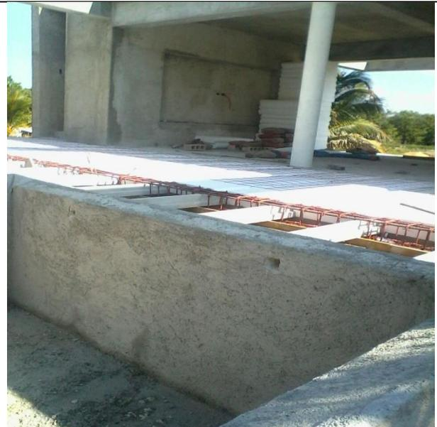
En cuanto a la piscina de la vivienda unifamiliar, esta se desplantará por debajo del nivel de piso (según planos). Se requerirá una pequeña excavación de cimentación (para cada piscina) a base de mampostería con sus respectivas cadenas de cimentación y castillos, piso con malla electrosoldada con colado de pisos así como paredes con concreto, recubiertos con un acabado de cemento blanco para impedir filtraciones.
