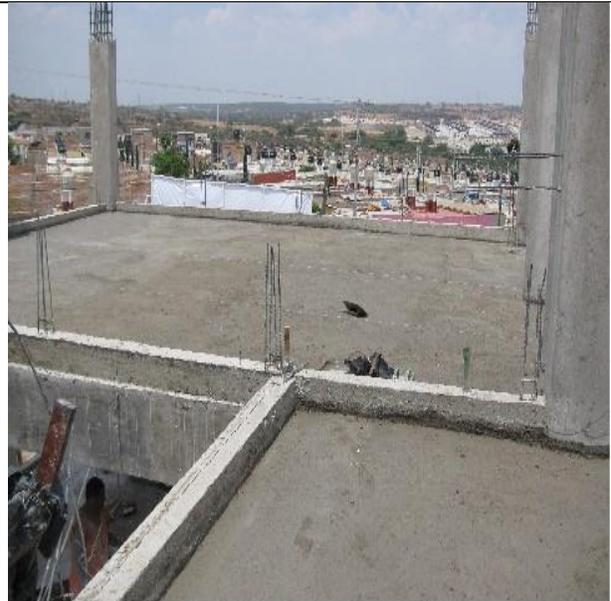
Como se puede ver en la imagen de referencia, las cadenas y castillos son colados con concreto. Así mismo, para el colado del piso se colocar una parilla de malla electrosoldada donde se vertirá el concreto del piso del primer nivel de la vivienda unifamiliar.
