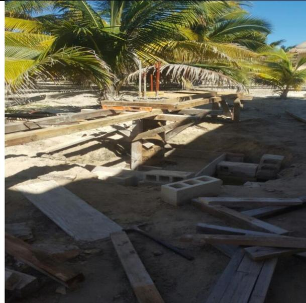
Una vez fraguadas las zapatas y cimbras, se procede a rellenar las cepas con el material de arena removido previamente. Así mismo, sobre los pilotes resultantes se procede a colocar un encimbrado para colar las traves que servirán para soportar las viguetas y bovedillas que conformaran el piso dela vivienda unifamiliar.
