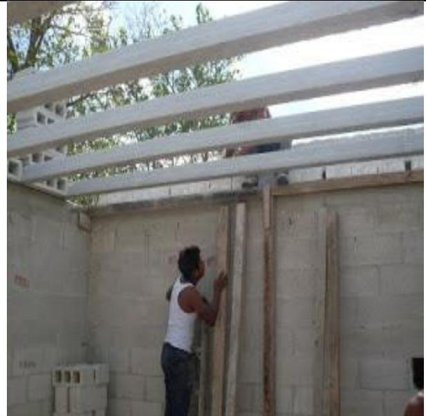
Una vez realizado el colado de cerramientos se procede a asentar viguetas y bovedillas para conformar el techado del primer nivel de la vivienda unifamiliar.
