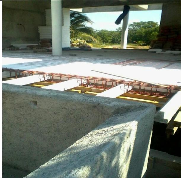
Una vez fraguadas las traves se procede a remoer las cimbras de madera y se dispone a asentarse viguetas y bovedillas, las cuales posteriormente serán coladas con concreto para dar soporte al piso. Asi mismo se procede a alinear las cadenas que servirán para sostener los muros de block de la vivienda unifamiliar.
