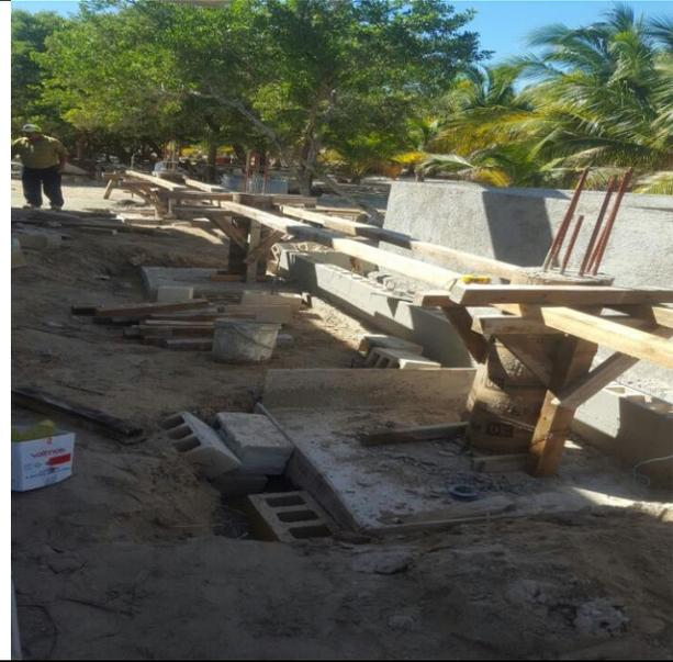
En virtud de que el autor de este documento a supervisado la construcción de proyectos similares en esta zona denominada como el “palmar” se manifiesta que es necesaria la excavación de cepas de 2 x 2 metros de ancho con dos metros de profundidad para la conformación de zapatas aisladas, con necesidad del uso de una bomba de achique para el desasolve del agua que pudiera salir.
