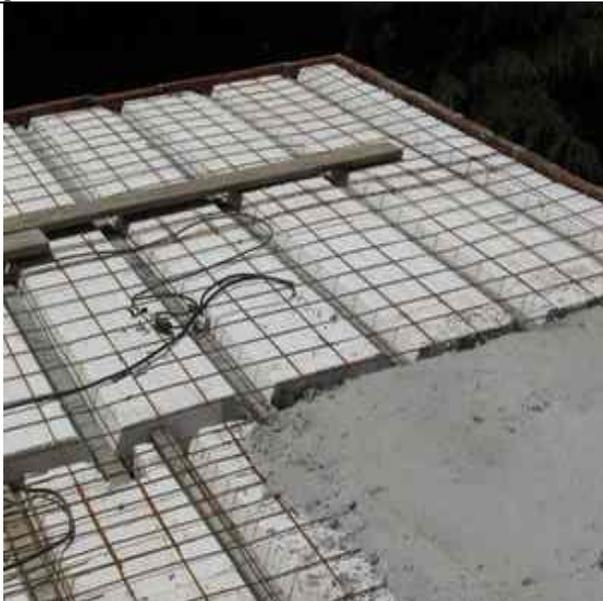
Una vez dispuesta la configuración de viguetas y bovedillas se procede a colocar malla electrosoldada y realizar un colado de concreto para proceder a desplantar cadenas y castillos del segundo nivel de la vivienda unifamiliar para de estar forma repetir el proceso constructivo ya mencionado
