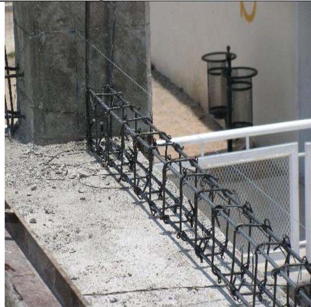
Como se menciona, resultará necesaria la colocación de armex para el colado y conformación de las cadenas y castillos de cimentación para sostener muros.
