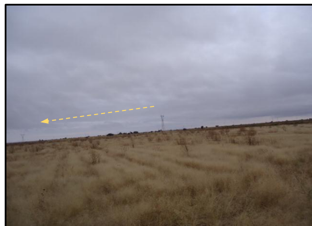
Línea de Transmisión Calera Industrial, al interior del predio del proyecto.
