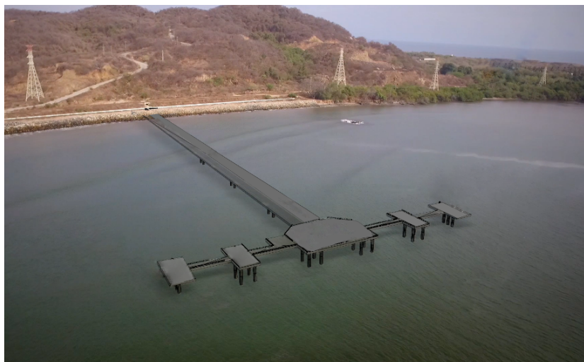
Ilustración No.7. Vista de los componentes del muelle
