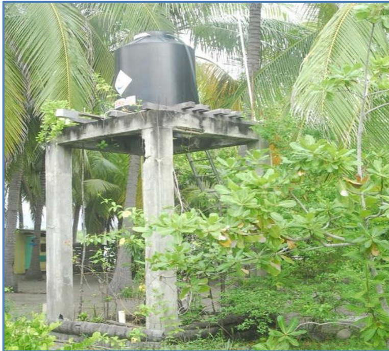
**Figura 4.** Vista del tanque tipo rotoplást montado sobre una estructura elevada.
