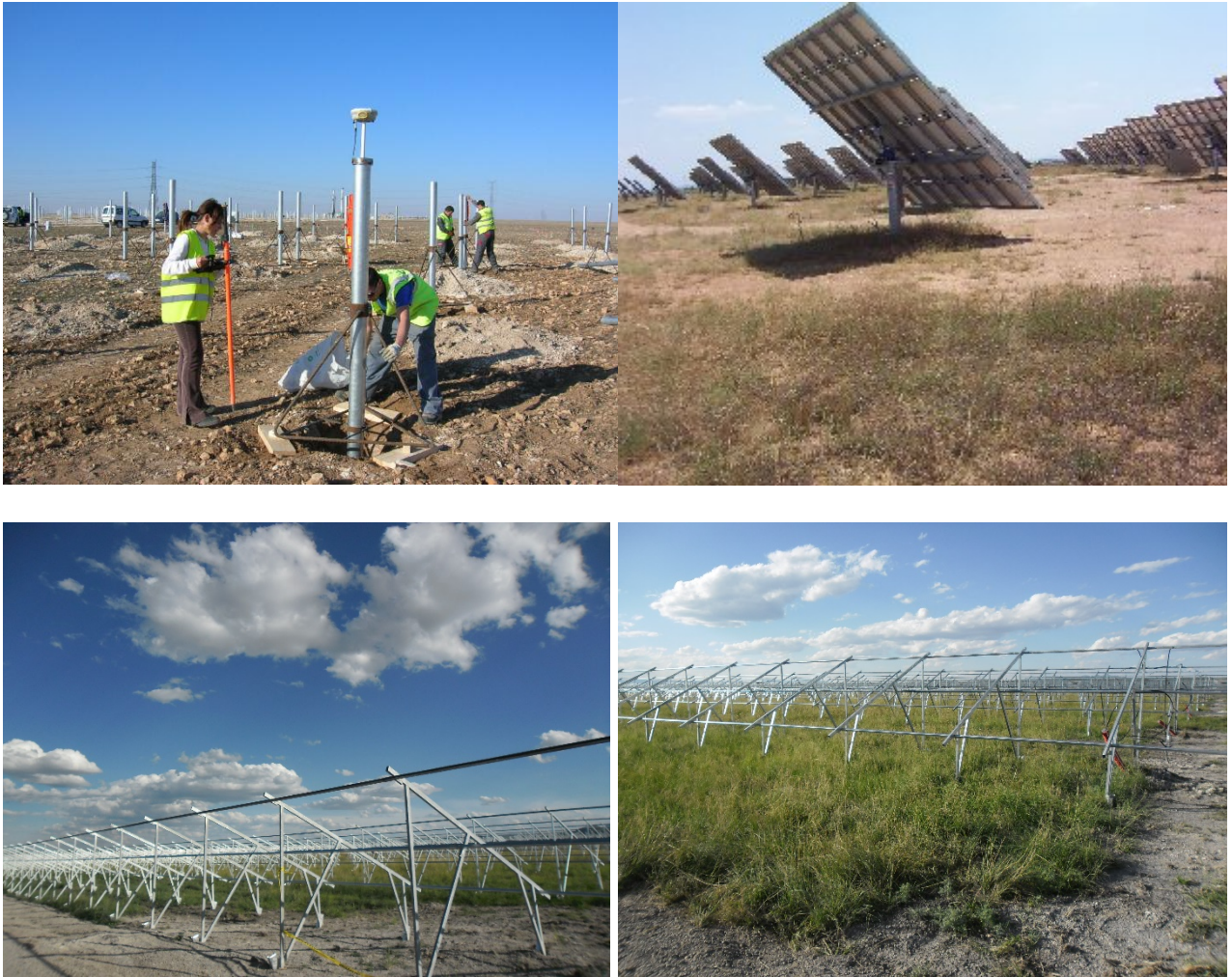
Fig. 69. Infraestructura de anclaje para el área de paneles solares, que se tiene en otros huertos solares.
