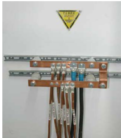
Fig. 7. Configuración del cableado de tierra de protección
