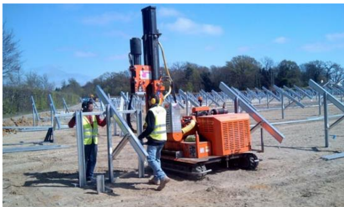
Fig. 13. Hincado de estructuras
