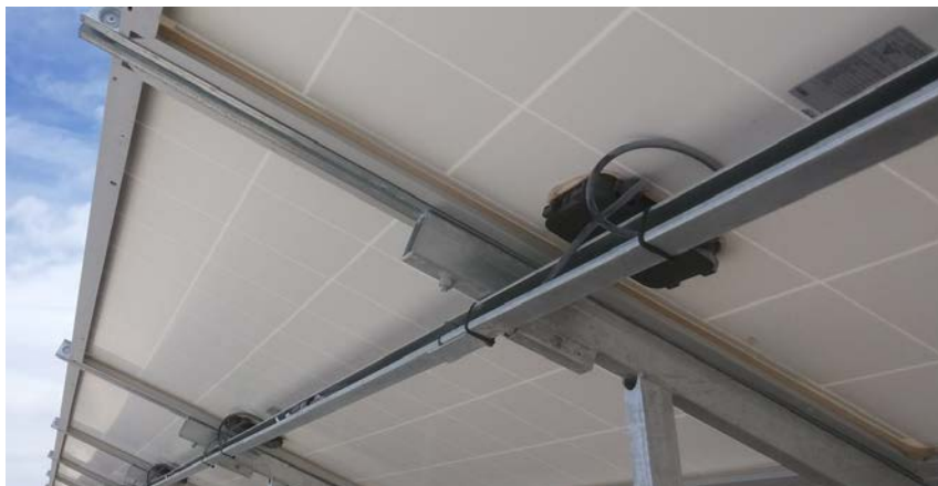
Fig. 22. Cableado de panel
