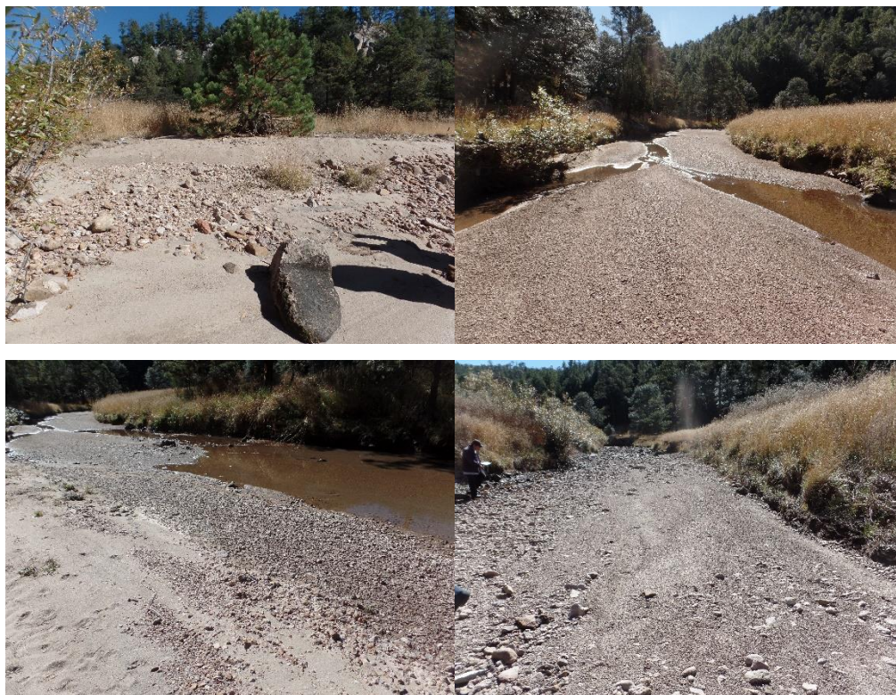
Figura 4. Panorámicas del cauce donde se muestra la ausencia de vegetación
