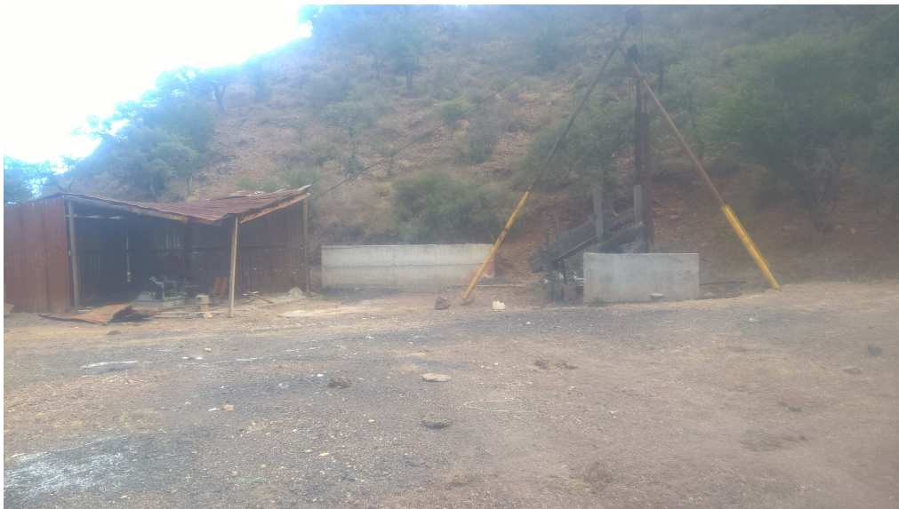
Foto 8. Patio del tiro de mina moreslo
