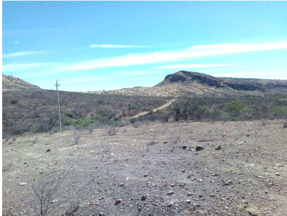
Foto 3; Línea de CFE de 34,000 volts existente con localización de poste para interconexión de red de suministro a Mina Morelos.
