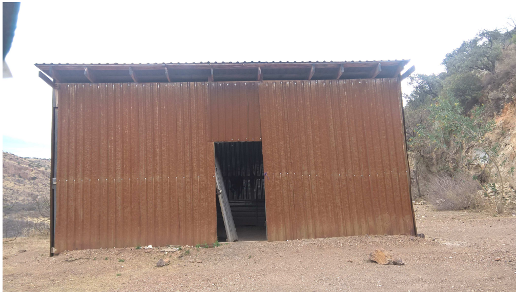
Foto 12, Campamento del personal
