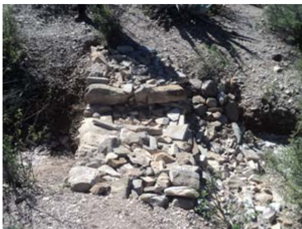
Figura 22. Propuesta para la construcción de Presas filtrantes de piedra acomodada
