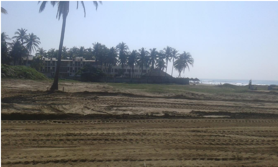
Foto N° 1 Preparación y nivelación del Sitio
