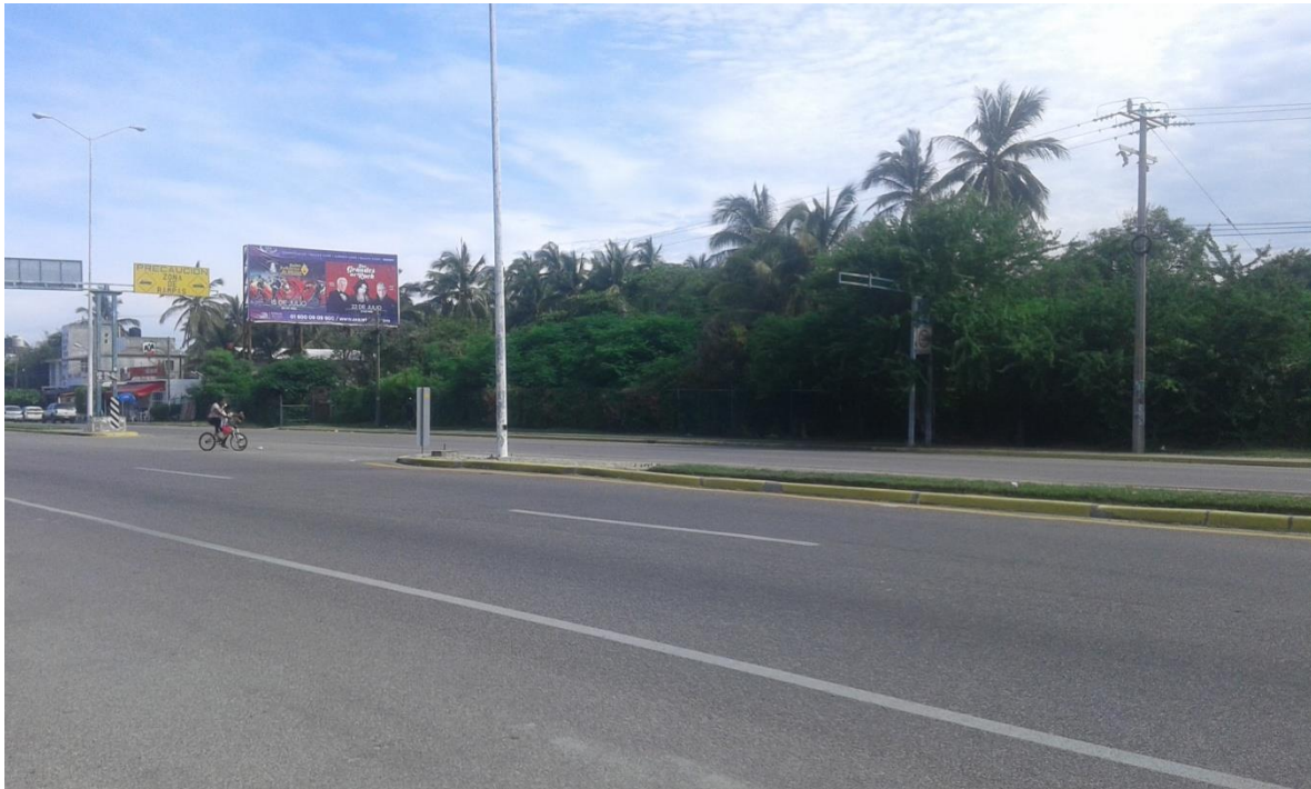
Foto N° 4 Vialidad de acceso al proyecto boulevard Barra Vieja
