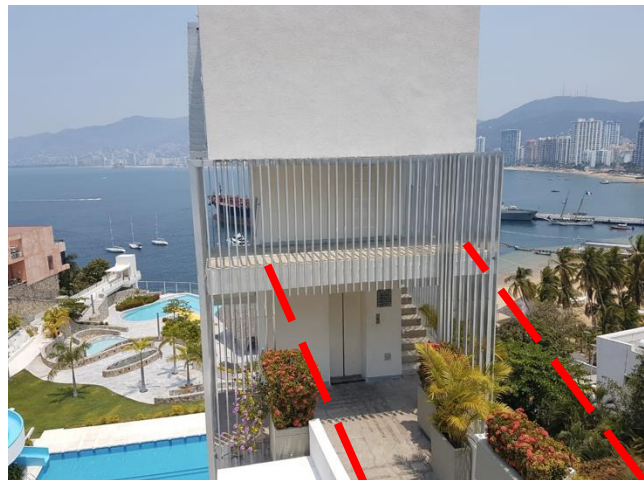
Cubo de elevador actual que se incrementará un nivel para conectar con rampa propuesta
