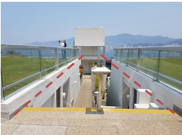
Sitio donde se pretende colocar la rampa para personas de la tercera edad o con capacidades diferentes y evitar bajen escaleras.
