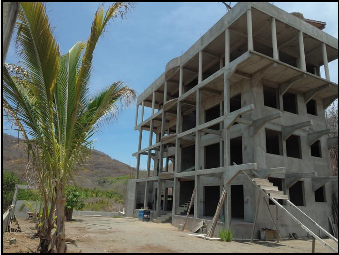
Imagen 40.- Estructura del Hotel con un avance del 65%.
