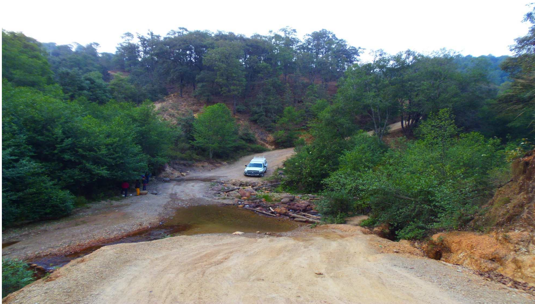
Vista panorámica del donde se ubicara el puente.
