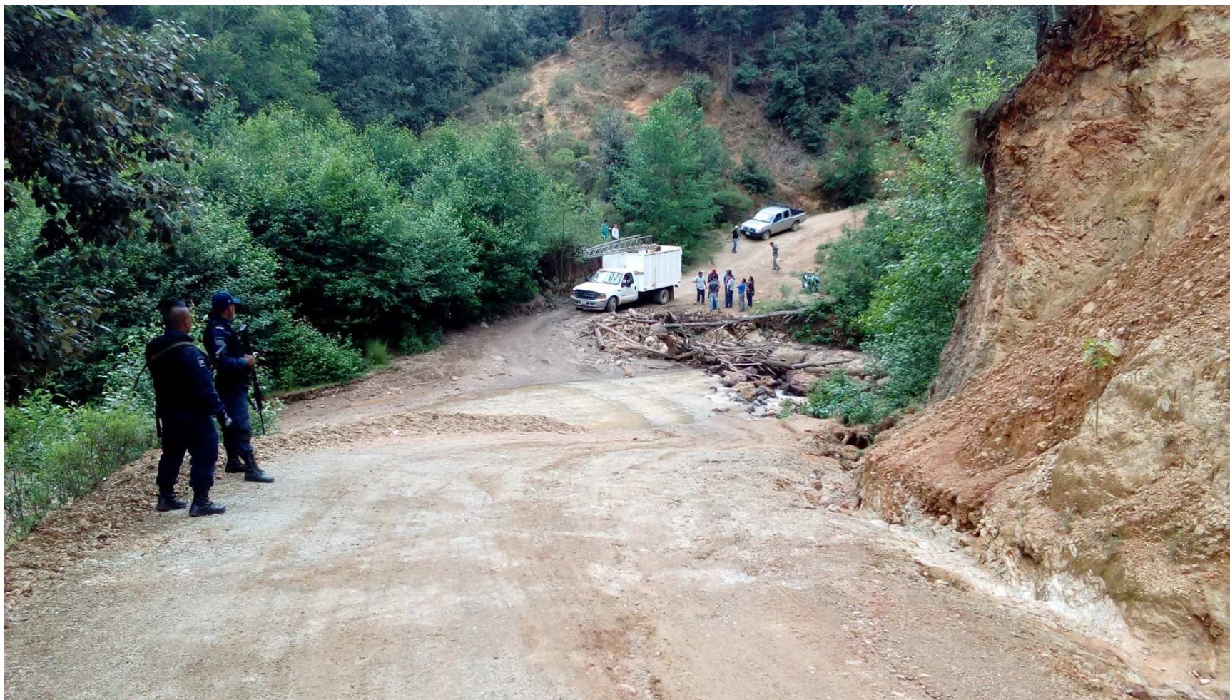
Vista del bloqueo del paso, por los socavones creados y derrumbes provocados por las lluvias.
