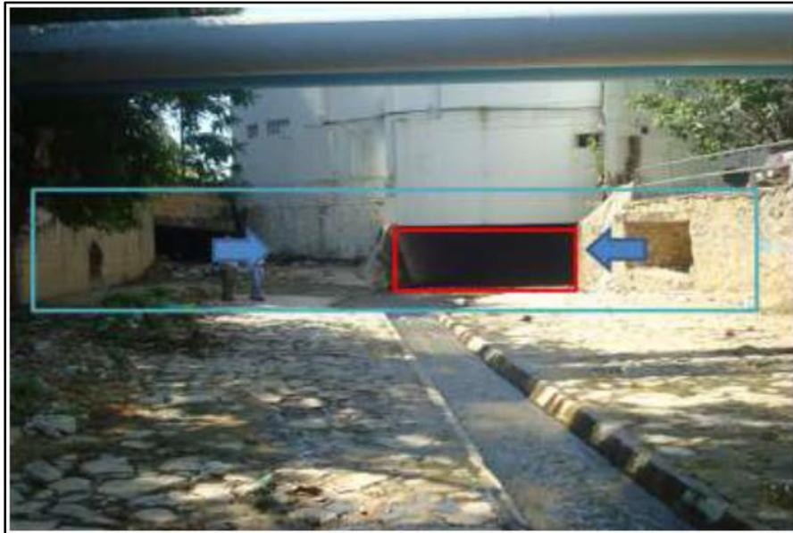
Figura II.1. Reducción de la sección del cauce del río La Garita y afluencia de dos corrientes tributarias a la altura de la gasolinera en "La Diana". La sección de color azul se propone con el desarrollo del proyecto.
