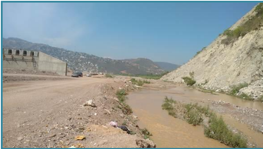
Foto 1.- Vista del banco dirección Este
