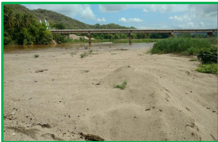
Foto 1.- Colindancia al norte con el puente vehicular
