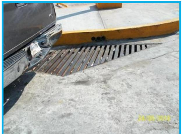
Foto 11 y 12. Rejillas de agua pluvial que se sustituirán
