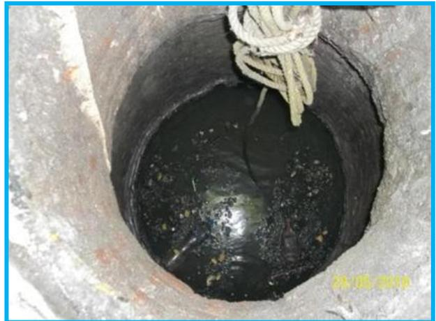
Foto 15 y 16. Área del colector en foco de infección y a sustituir por estar saturado
