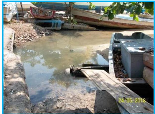
Foto 9 y 10. Salida de agua pluvial que se clausurara, y será dirigido al colector general
