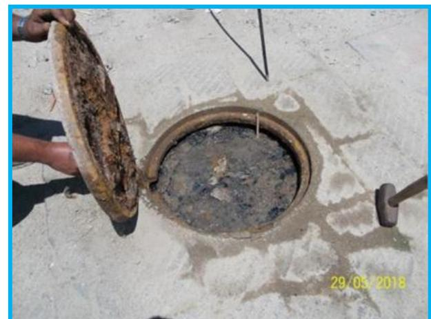
Foto 17 y 18. Colector en malas condiciones por estar saturado
