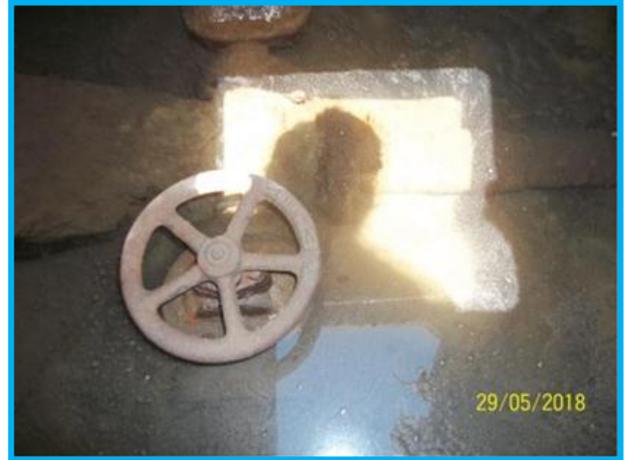
Foto 7 y 8. Tomas de agua potable en mal estado
