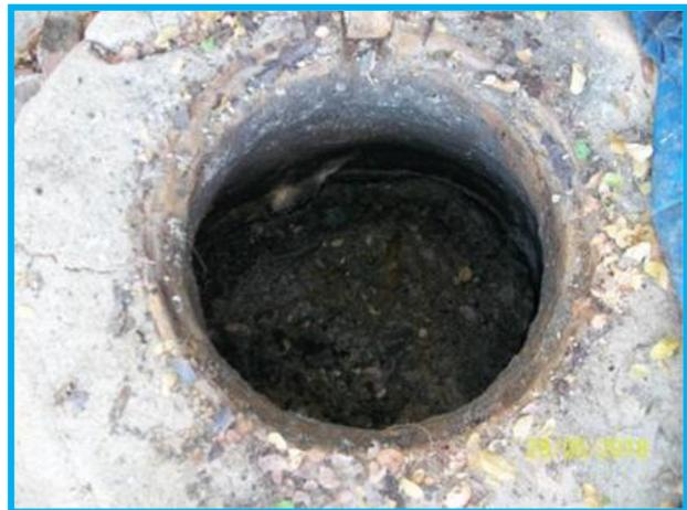
Foto 5 y 6. Drenaje sanitario (colector) en mal estado
