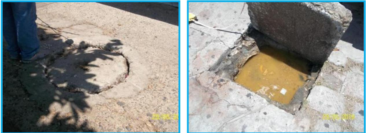
Foto 19 y 20. Tapas de drenajes antiguas y colector saturado a sustituir
