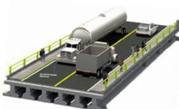
losas apoyadas sobre vigas de concreto reforzado, sobre traveses tipo AASHTO, armaduras, etc.
