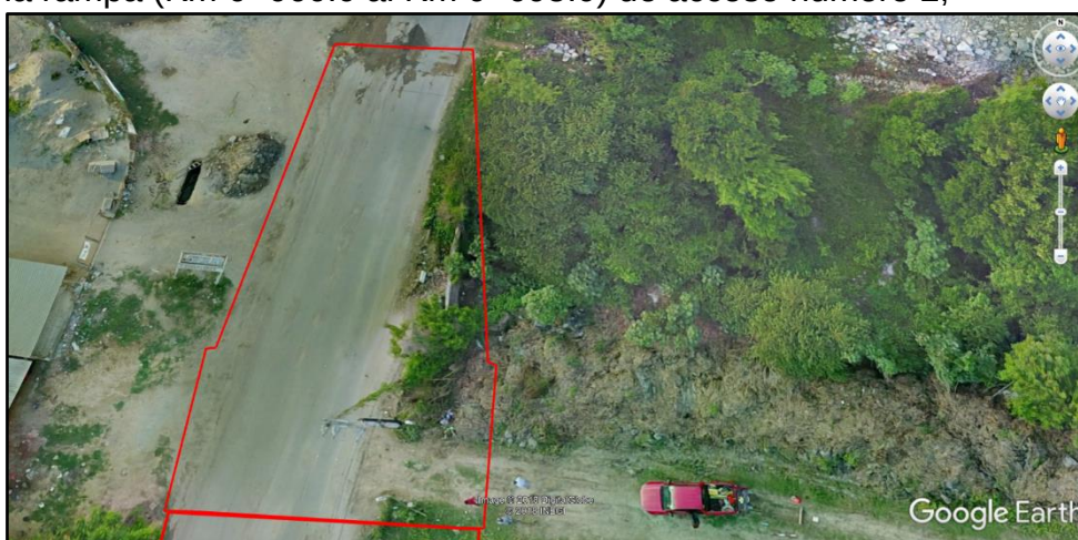
Imagen 15. Vista Aérea de la Segunda Rampa del Puente Vehicular; nótese la escasa vegetación dentro de esta.
