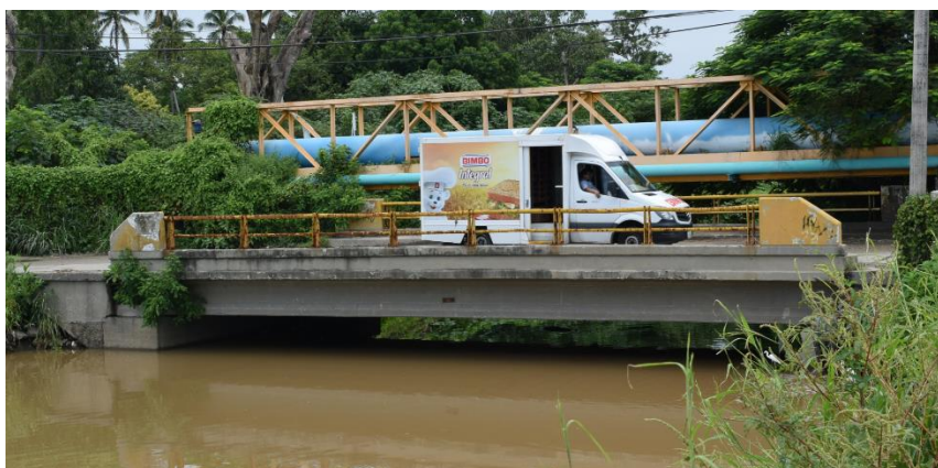
Imagen 8. Puente Vehicular Existente.
