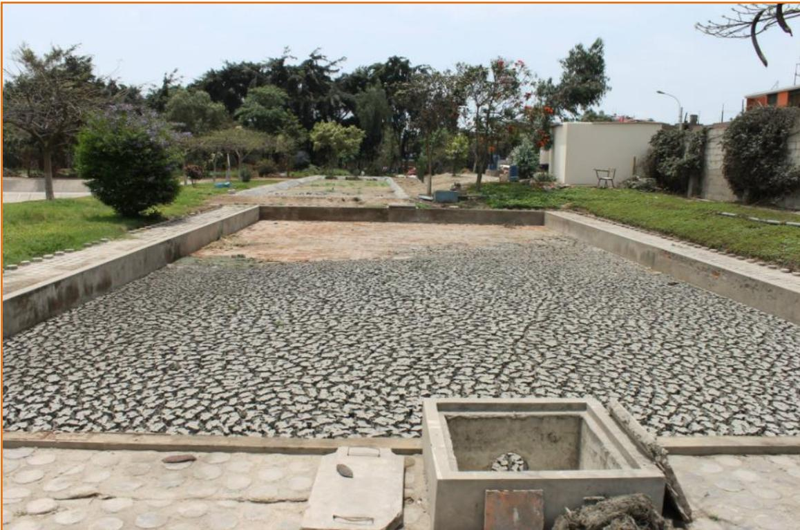
Fotografía No II.1: Tarquina con muros de concreto.
