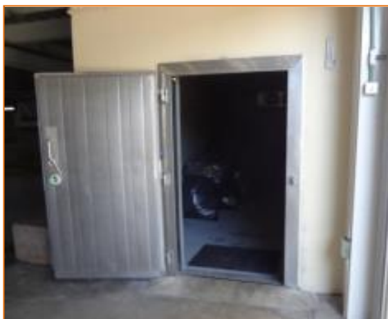
Fotografía No 1: Cámara de almacenaje de residuos orgánicos
