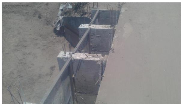
Imagen 3. Estructura de las compuertas de entrada y salida de agua en la granja, construidas a base de concreto.
