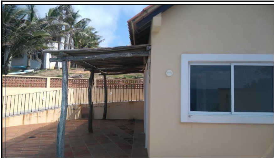
Barda, andador de acceso a una cabaña construida con concreto, todo totalmente terminado y en operación en el sitio del proyecto.
