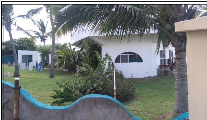
Casa construida y habitada en el lote 3, colindante al poniente con el lote 4.
