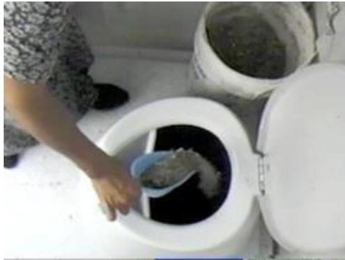
Cuando se llena el tanque en uso se cambia el asiento al segundo tanque y el primer tanque se cubre.
