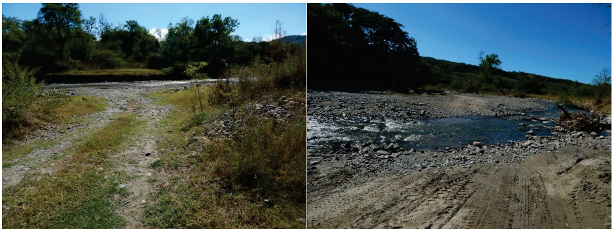
Vista del camino de acceso que llega hasta el sitio del proyecto y cruza el cauce
